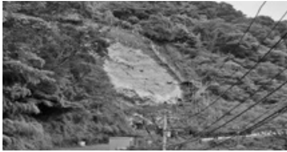
オレンジラインがけ崩れ (R2.8.16撮影)
