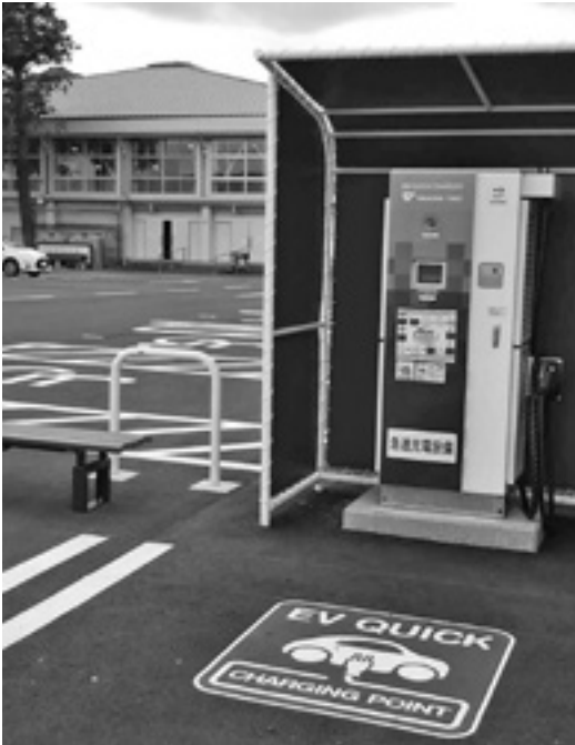
整備された町民体育館駐車場及び急速充電器
