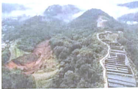
①土石流の起点となった盛り土の崩落現場(左)と同じ会社が開発したソーラーパネル(右)＝7月3日、本社へりから
