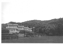
太陽光設置が予定される丹那小学校の裏山
